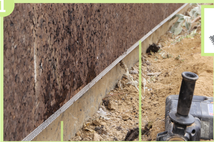
Profil de socle aluminium en U
