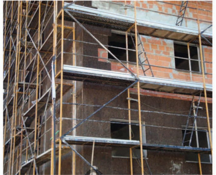
Immeuble d'habitation - Santarém, PORTUGAL (Système FAÇADES)
