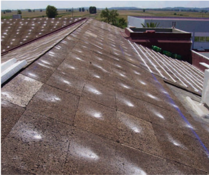
Centre de stages sportifs de Golegã - Golegã, PORTUGAL (Isolation des toitures inclinées)
