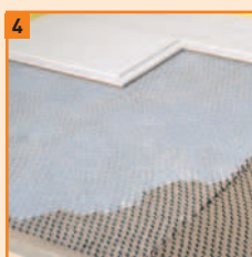
4 Mise en place des plaques de sol.
