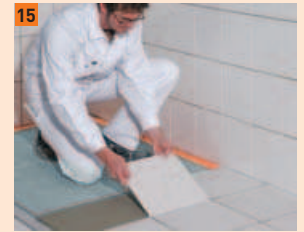
15 Coller le carrelage en couche fine ou moyenne
