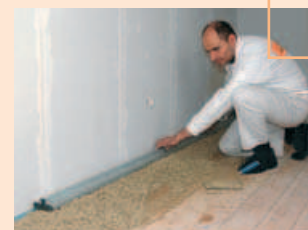
Créer la première digue
