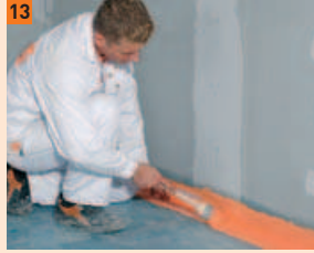
13 En un deuxième passage recouvrir le tout avec l'étanchéité liquide FERMACELL
