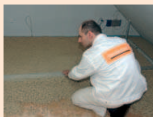
Comblé l'espace entre les deux digues avec du mortier d'égalisation
