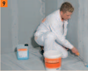
9 Appliquer le primaire FERMACELL sur les cloisons...
