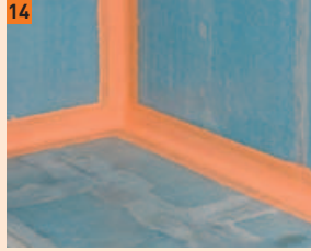
14 Lors d'une sollicitation faible à modérée à l'eau seul les angles sont traités avec le système d'étanchéité FERMACELL
