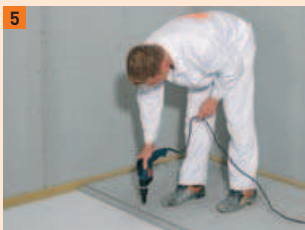
5 Assembler avec les vis Powerpanel...
