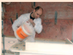
Rajouter 8 à 10 litres d'eau par sac
