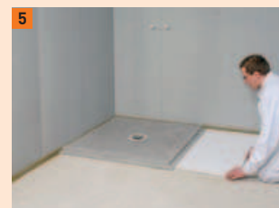
5 Variante 1b suite : Pour compenser la sur-épaisseur du receveur de douche, poser une plaque de polystyrène expansé de 10 mm (EPS DEO 150) sur le mortier d'égalisation
