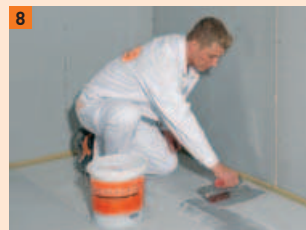
8 Enduire les fixations et les joints si nécessaire
