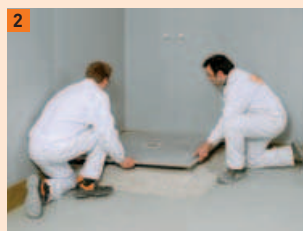
2 Variante 1a : Ragréer la zone du receveur de douche avec le mortier d'égalisation FERMACELL au niveau du boîtier d'écoulement. Après séchage, placer le receveur
