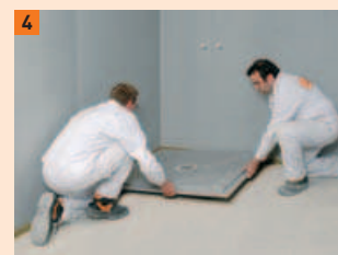
4 Variante 1b : Ragréer toute la surface avec le mortier d'égalisation FERMACELL au niveau du boîtier d'écoulement. Après séchage, placer le receveur
