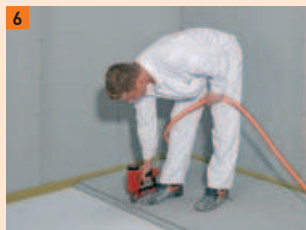
6 ...ou des agrafes divergentes de 22 mm
