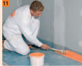
11 Appliquer avec un pinceau l'étanchéité liquide FERMACELL dans les angles
