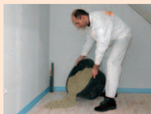
Après le mélange, le mortier d'égalisation a une humidité comparable à de la terre
