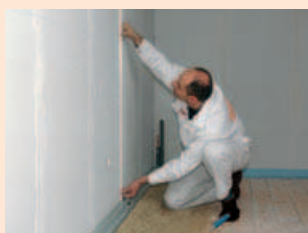
Contrôler la hauteur de ragréage
