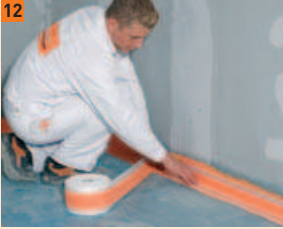
12 Presser la bande d'étanchéité FERMACELL dans le lit d'étanchéité encore liquide
