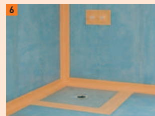
6 Poser les plaques de sol Powerpanel TE (coller et visser). Enduire la surface avec du primaire FERMACELL, puis étancher les raccords avec le système d'étanchéité FERMACELL pièce
